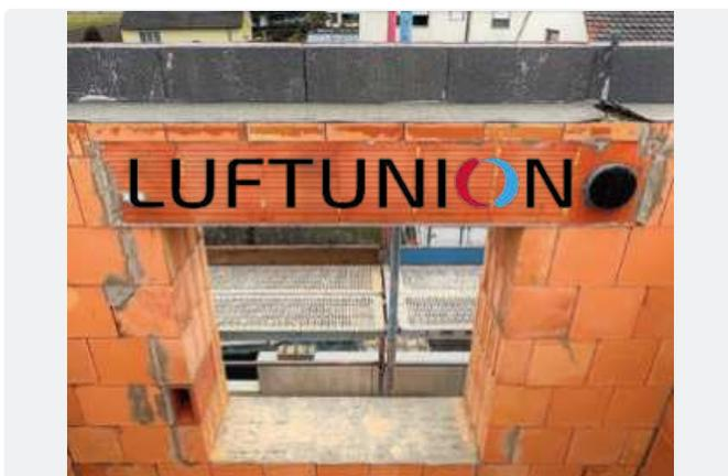
Beispiel Montage eines Rollokastens
