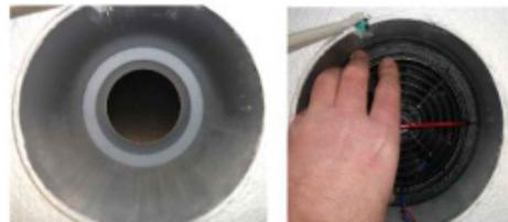
**! Wichtig:** Der Kondensatablauf (erkennbar an den Ventilator-kabeln des Lüfterantriebs) muss sich auf **Position 6 Uhr** befinden!
