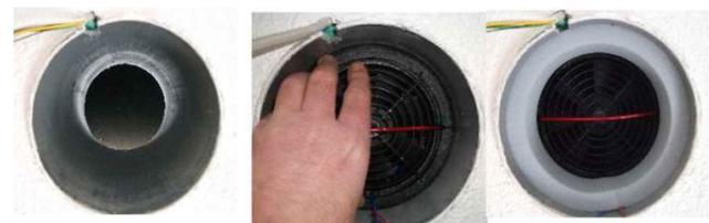
**!** **Wichtig:** Der Kondensatablauf (erkennbar an den Ventilator Kabeln des Lüfterantriebs) muss sich auf **Position 6 Uhr** befinden!
